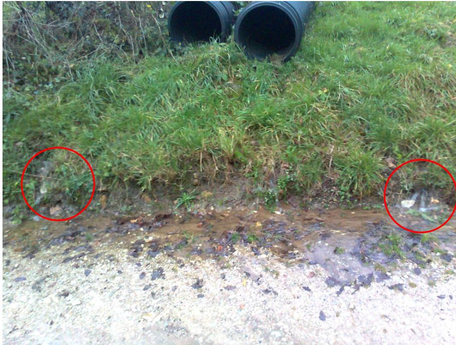
Figure 11 : Eau jaillissant du sol dans le périmètre de protection immédiat du captage
