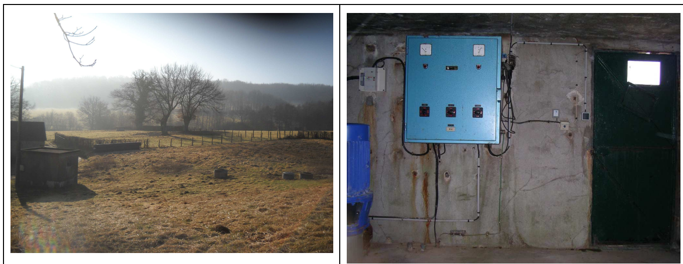
Figure 4 : Vue extérieure et intérieure du captage
